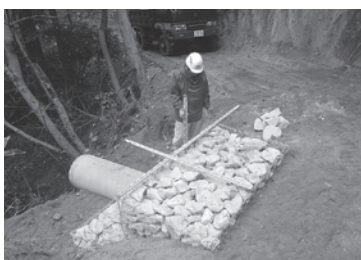
⑥ヒューム管設置完成
