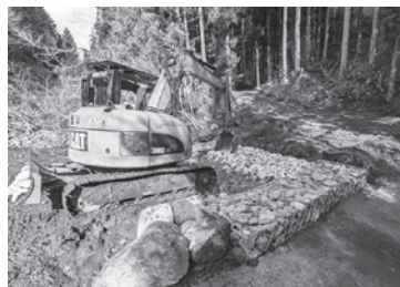
②栗石の敷設
