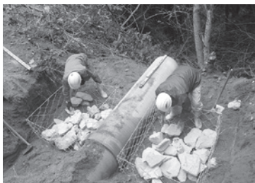
⑤フトンカゴの設置
