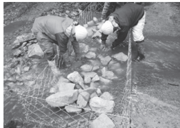
①フトンカゴの設置
