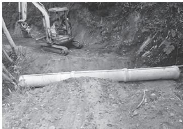
④ヒューム管の設置
